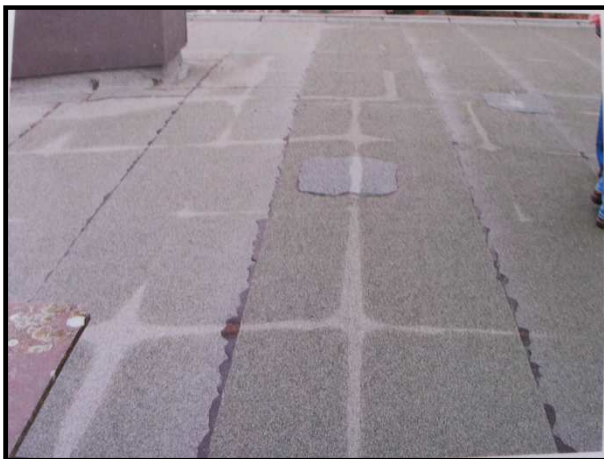
Obr. 4.4 Viditelné obrysy spárové struktury
