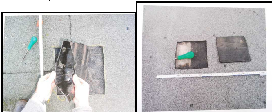
Obr.4.2 Po otevření střechy byla odhalena příčina poruchy: pásy z asfaltu modifikovaného SBS nebyly svařeny celoplošně.
