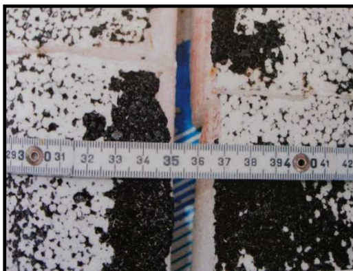
Obr. 4.7 Příliš široké spáry v tepelněizolační vrstvě
