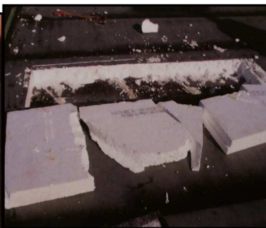
Obr. 4.22 Rozebrání tepelněizolační vrstvy
