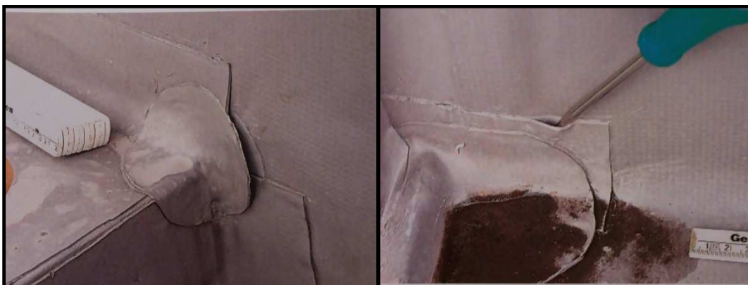
Obr.4.13 Otevřená ukončení rohů
