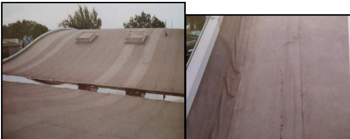
Obr.4.15 Zvlněná střešní kce sse zateplenou Hydroizolací z fólie z mPVC
