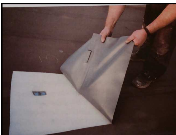
Obr.4.21 Střešní kotvy jsou uvolněné.
