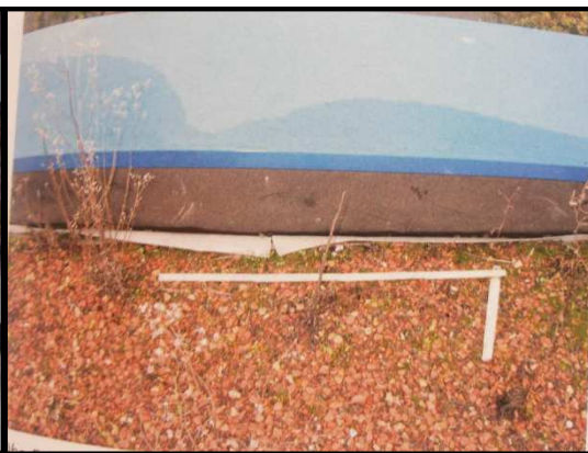
Obr. 4.26 Ochrana proti prorůstání kořenu bez ukončení na kraji
