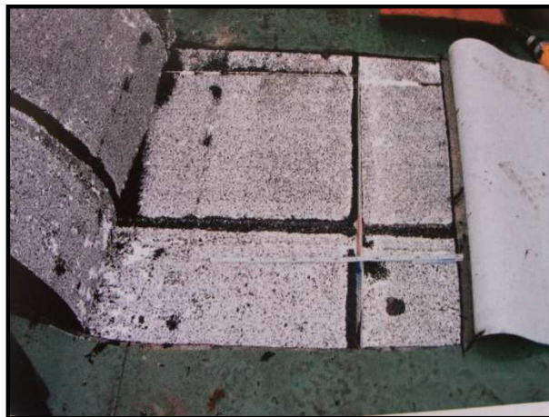
Obr. 4.5 Příliš široké spáry v tepelněizolační vrstvě
