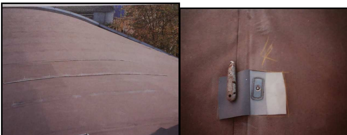
Obr.4.19 Střešní kotvy jsou uvolněné.
