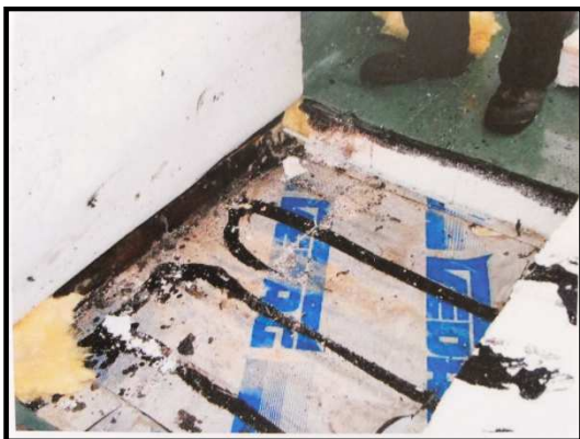
Obr. 4.6 Jedna z příčin poruchy: pohyb tepelněizolačního izolačního materiálu zapříčinilo použití elastického lepidla
