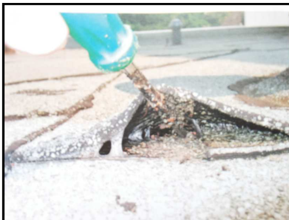
Obr. 4.1 Voda kapilárně penetrovala pod přesah
