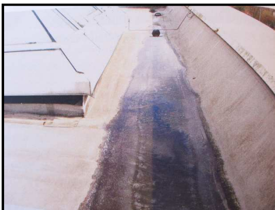
Obr. 4.8 V žlabové části u atik je stojatá voda Obr. 4.9 Skutečná příčina je vliv aktivního uhlí
