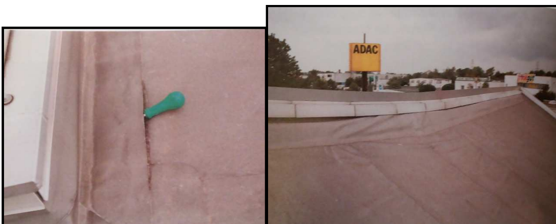
Obr.4.17 Dva typy netěsností
